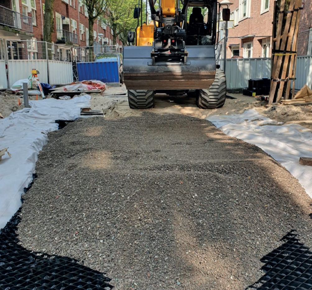
granovla DRAINMIX is een secundaire grondstof die uitermate geschikt is om zand en grind te vervangen in beton, bijvoorbeeld als waterbufferend pakket voor bestrating
